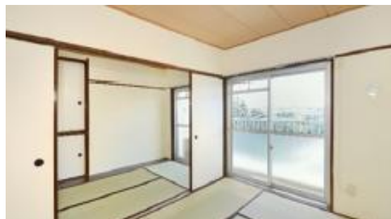
リニューアル施工前
