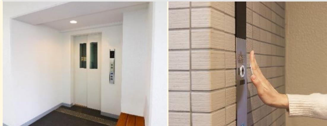
ボタンに触れずに利用可能な赤外線式センサー採用(カームスト石川台)
