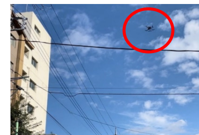
ドローンによる外壁赤外線調査 (コーシャハイム武蔵岡)
