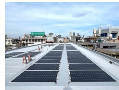
「超薄型軽量パネル」設置状況
