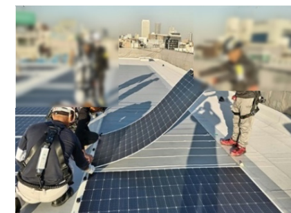
「超薄型軽量パネル」の貼り付け状況
