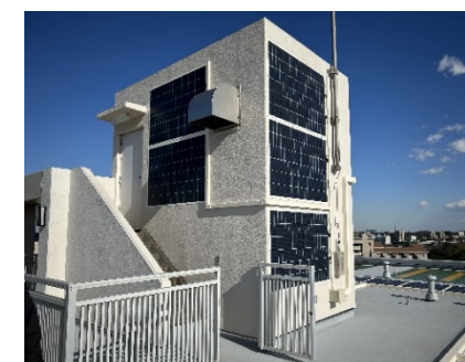
参考写真「薄膜パネル壁面貼付け」
