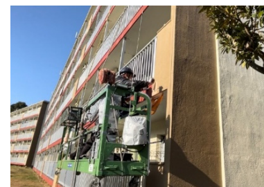
全面打診時のゴンドラでの塗装状況 (多摩ニュータウン松が谷)
