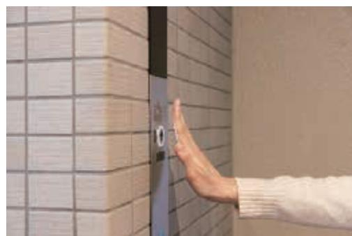
ボタンに触れずに利用可能な赤外線式センサー採用 (カーメスト石川台)
