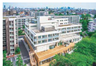
コーシャハイム向原 7 号棟 (サービス付き高齢者向け住宅、 介護系事業所、認可保育所等)
