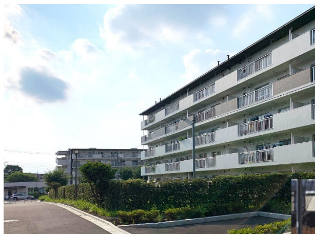
南大沢地区のJKK住宅
