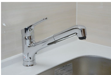
お湯のムダ使いを防ぎ省エネに寄与するエコタイプ水栓
