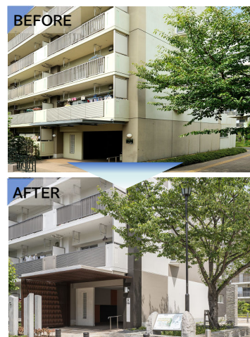
<外壁・エントランスリニューアル>
