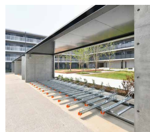
自転車置場 (屋外) (写真は2号棟)
