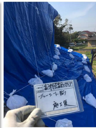
復旧作業の様子
