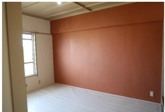
DIY：ビニールクロス貼り
