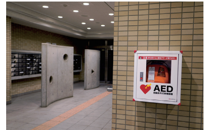
AED는 1층 현관에 설치
