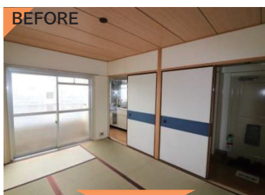
空家リニューアルの一例 <室内の間取り変更>
